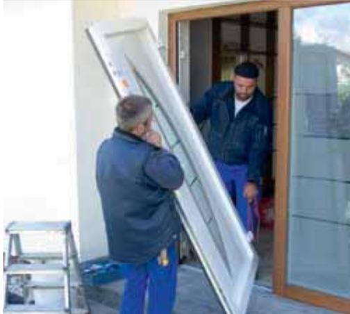
Schritt 2: Die neue Hörmann Haustür wird vom autorisierten Hörmann Partner maßgerecht eingebaut. Durch die spezielle Haustürschwelle werden die Übergänge vom Innen- zum Außenbereich sauber überdeckt. Die Befestigung nach unten erfolgt mit verdeckt liegenden Schrauben.
